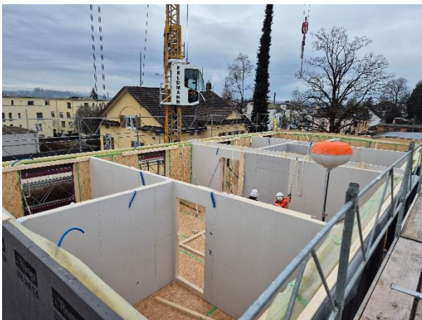
Hoher Vorfertigungsgrad durch Holzelementbauweise.
