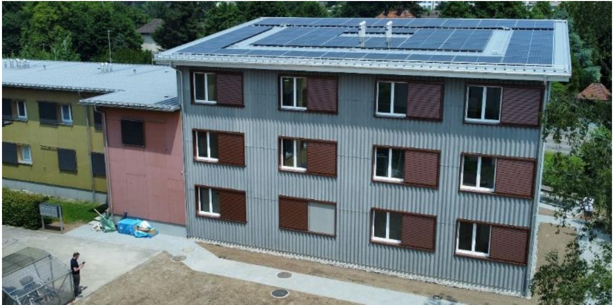
Südwestfassade mit barrierefreiem Gebäudezugang und Photovoltaikanlage.
