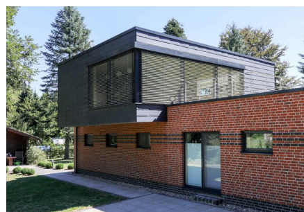
Referenzbilder realisierter Flachdach-Aufbauten
