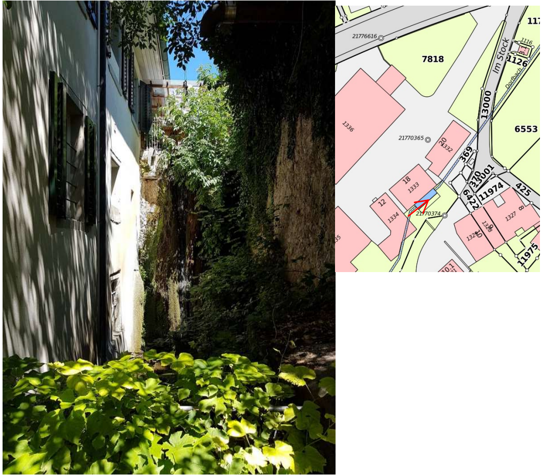
Abbildung 7: Hinterhof «Im Stock 18» mit kurzem offenen Absturzbauwerk
