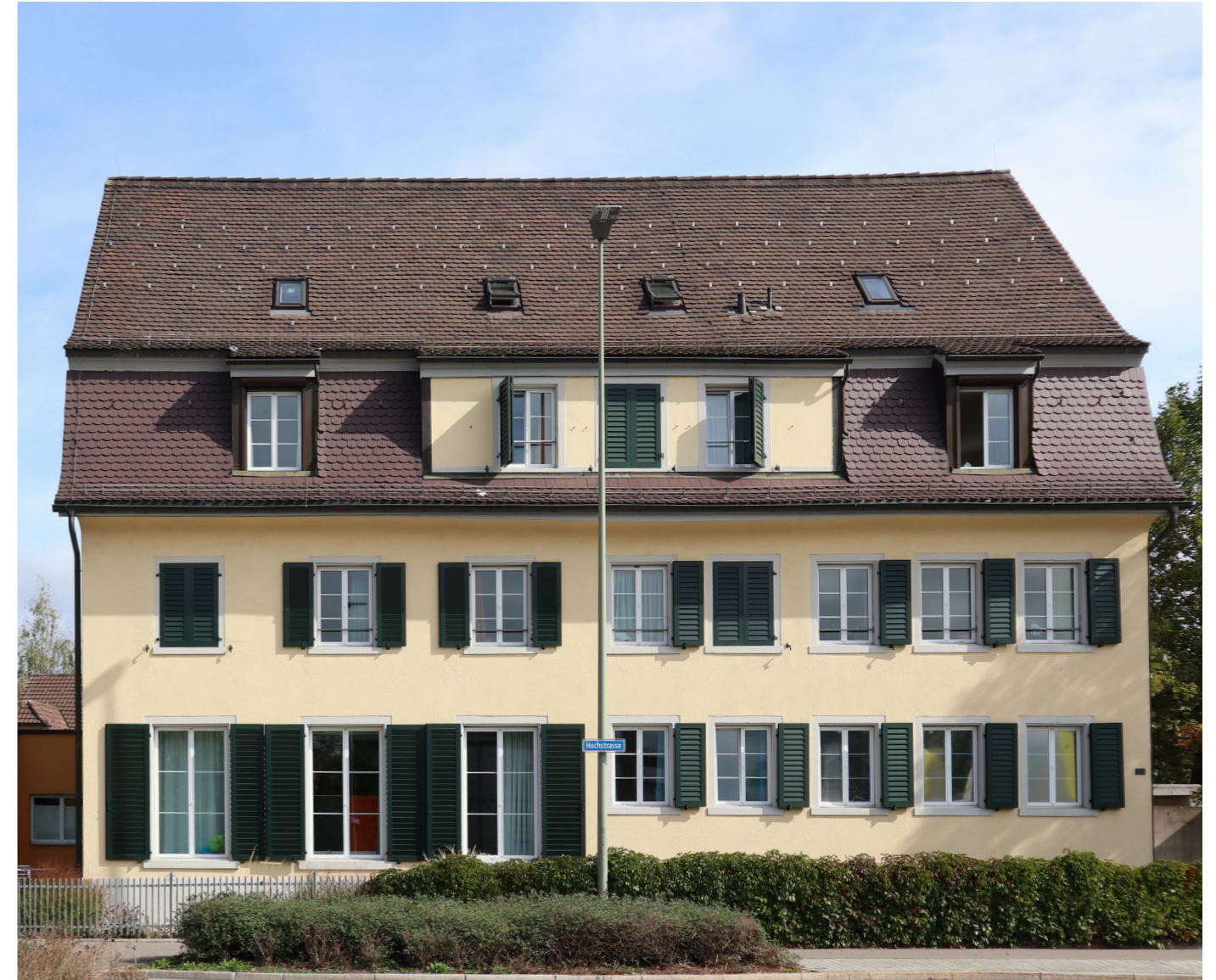
Südfassade von Hochstrasse aus
