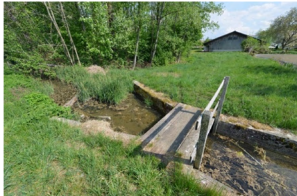
Wehr, Kanal mit Brücke © ARIAS Industriekultur, Colin Wiebking
