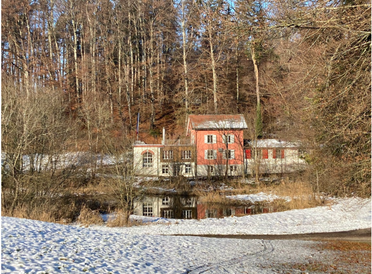
Ehemaliges Kraftwerk Weierholz, heute Pfadiheim, Foto © Hans Michael Schmitt, 2022
