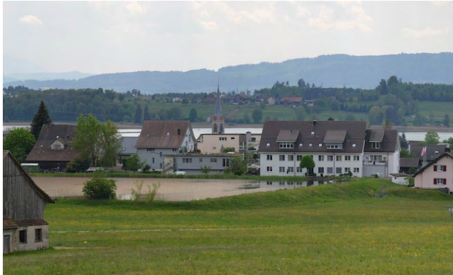
Mühleweiher mit Befestigungsdamm © ARIAS Industriekultur, Colin Wiebking
