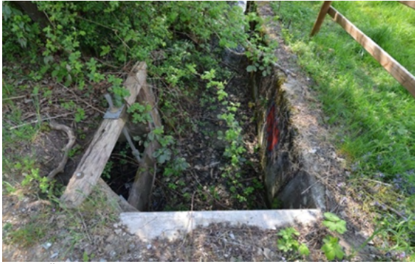
Wehr, Überlauf © ARIAS Industriekultur, Colin Wiebking
