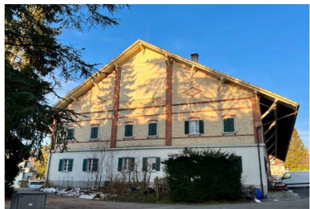
Areal 'Alte Mühle', Scheune mit Pferdestallungen & Wohnhaus
