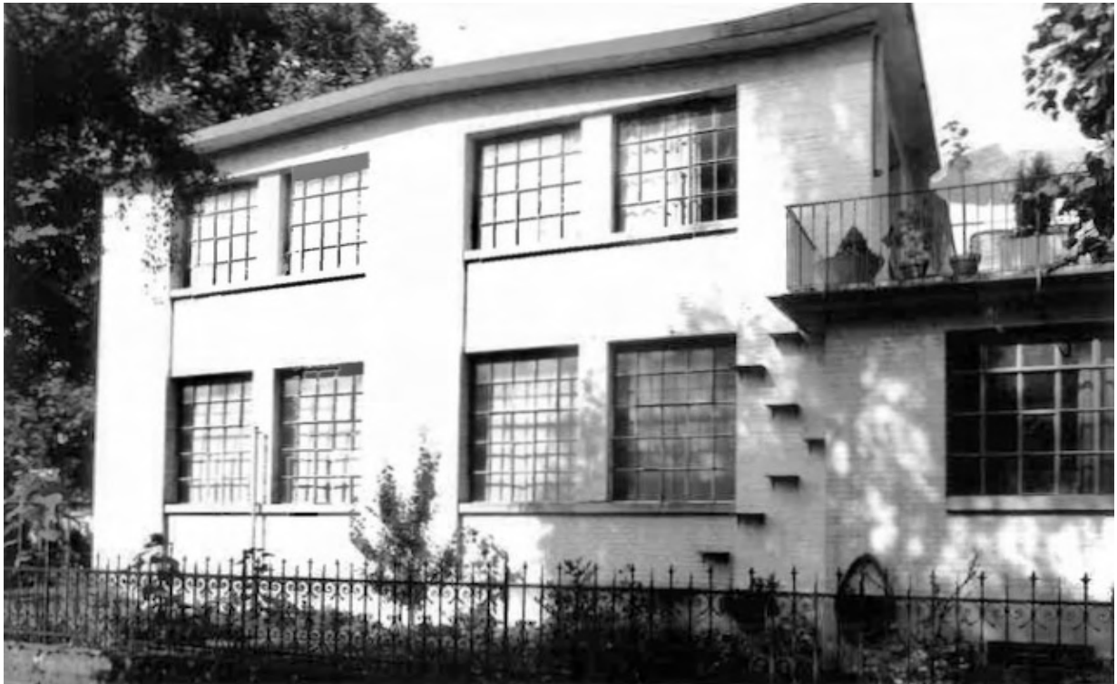
Schlosserei Schneider, um 1928, erbaut, bis 1957 genutzt. Südfassade © ARIAS Industriekultur, H.P. Bärtschi, aus: Kommunalem Inventar schutzwürdiger Objekte der Gemeinde Pfäffikon
