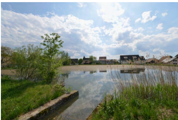
Unterwasserkanal, Austritt in den Mühleweiher © ARIAS Industriekultur, Colin Wiebking
