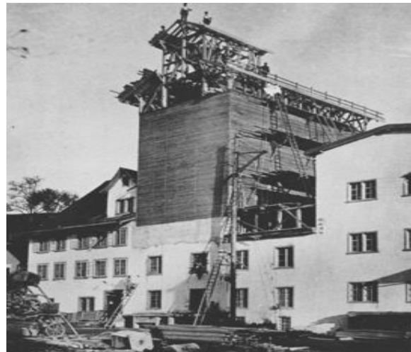
Symbol des Fortschritts – Bau des Hartweizensilos 1925
