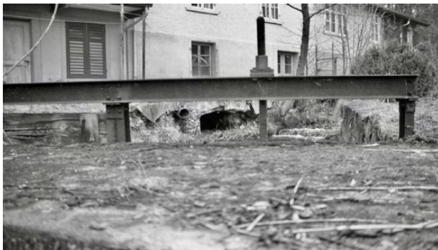
Kraftwerk, Einlauf ins Maschinenhaus des Elektrizitätswerks, Aufnahme 1980er Jahre Foto © H.P. Bärtschi, ARIAS Industriekultur, ETH e-pics
