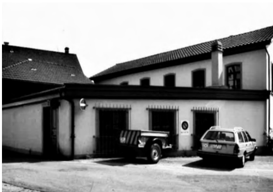
Fabrik, Ansicht von Nordwesten © ARIAS Industriekultur, H.P. Bärtschi, aus: Kommunalem Inventar schutzwürdiger Objekte der Gemeinde Pfäffikon
