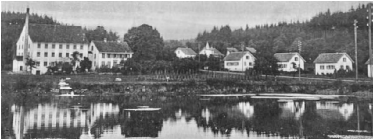
Fabrikanlage: Fabrik mit Hochkamin, dahinter Turbinenhaus & Fabrikantenwohnhaus (links); östlich der Fabrikanlage (links) oben am Hang die drei Häuser der Töchter mit freistehender Scheune & unterhalb vier Arbeiterhäuser; im Vordergrund der 'Mühleweiher'; Ansichtskarte 1922, in: ETH Pics, Fel_001566-RE
