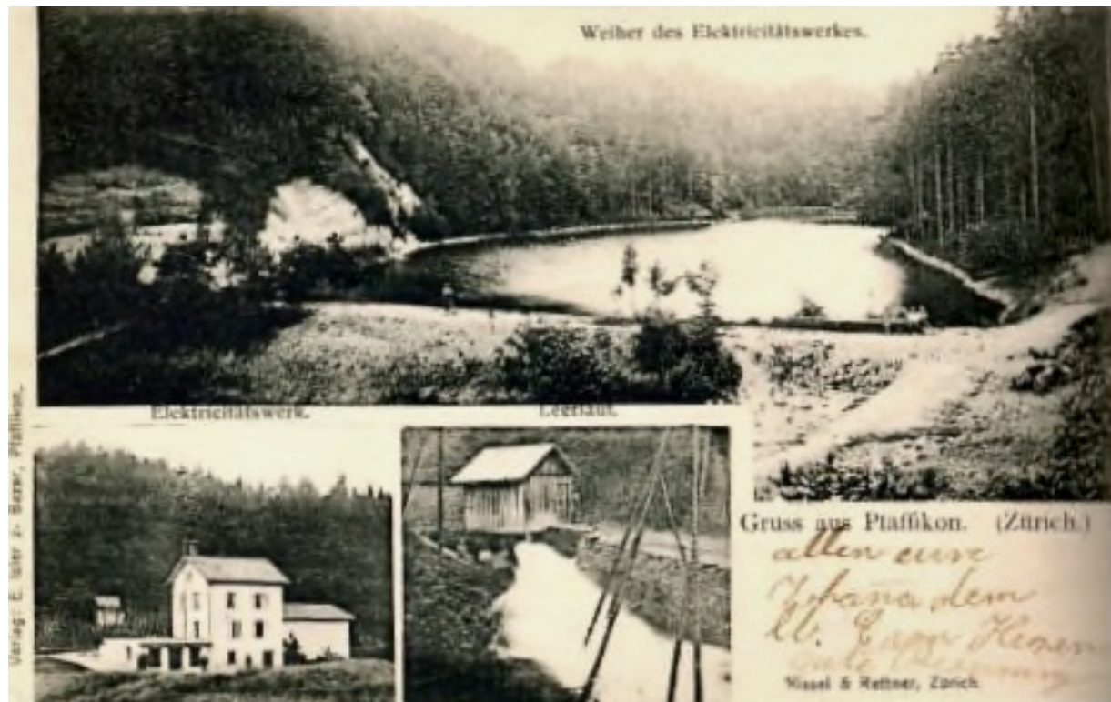
Postkarte 'Gruss aus Pfäffikon' mit Weiher, Elektrizitätswerk & Leerlauf, um 1911, Aus Frei, Beat, a.a.O., S. 84
