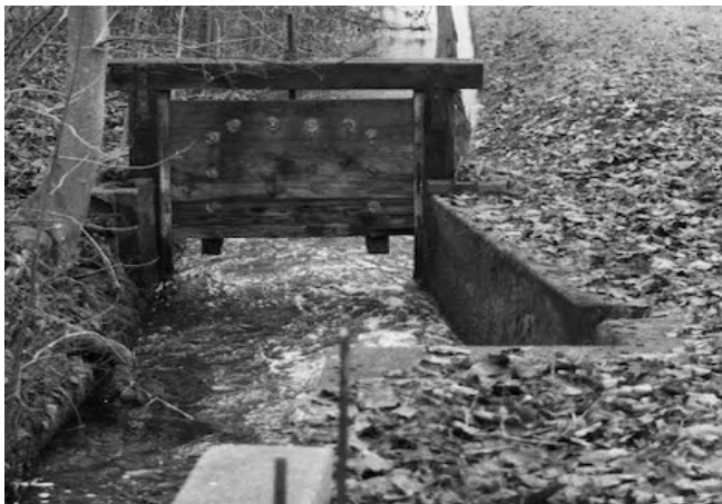
Kanal & Wehr zwischen Krebsi- und Mühleweiher mit Hubschütz © ARIAS Industriekultur, ETH E-Pics Stiftung H.P. Bärtschi
