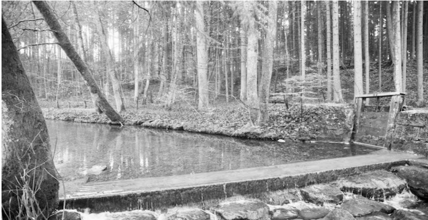
Schwelle an der Luppmen mit Kanaleinlauf © ARIAS Industriekultur, ETH E-Pics Stiftung H.P. Bärtschi
