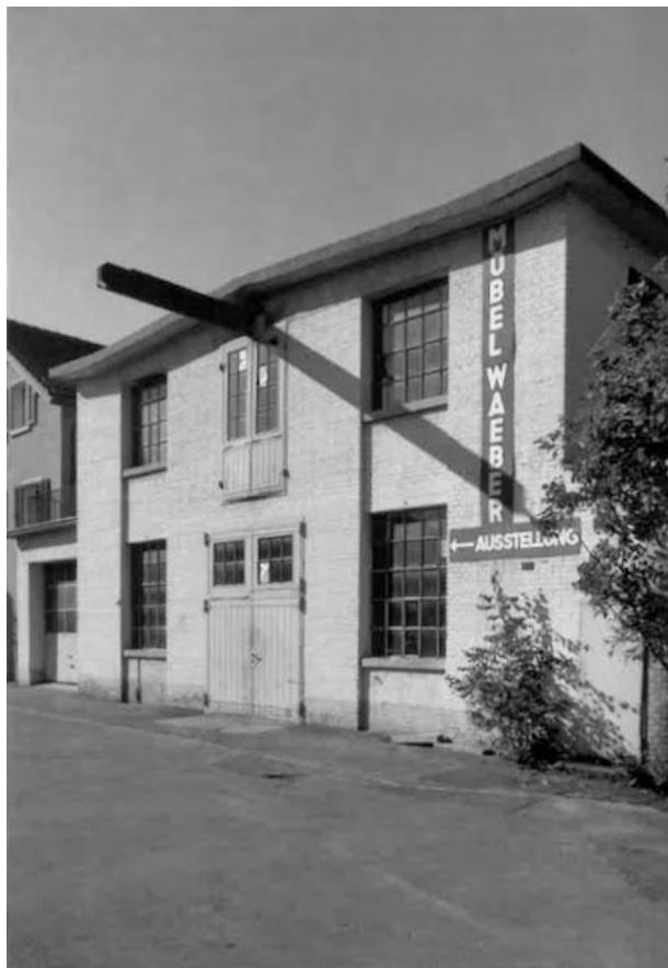
Fabrik, Nordfassade © ARIAS Industriekultur, H.P. Bärtschi, aus: Kommunalem Inventar schutzwürdiger Objekte der Gemeinde Pfäffikon
