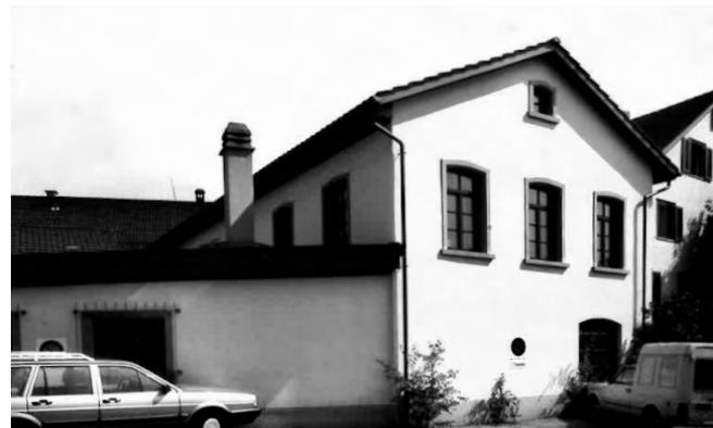
Fabrik, Ansicht von Nordwesten © ARIAS Industriekultur, H.P. Bärtschi, aus: Kommunalem Inventar schutzwürdiger Objekte der Gemeinde Pfäffikon
