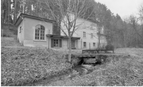
Kraftwerk mit Maschinenhausanbau, Aufnahme 1980er Jahre Foto © H.P. Bärtschi, ARIAS Industriekultur, ETH e-pics
