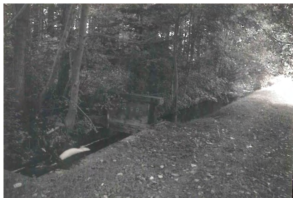
Unterwasserkanal mit Hubschütze © ARIAS Industriekultur, ETH E-Pics Stiftung H.P. Bärtschi
