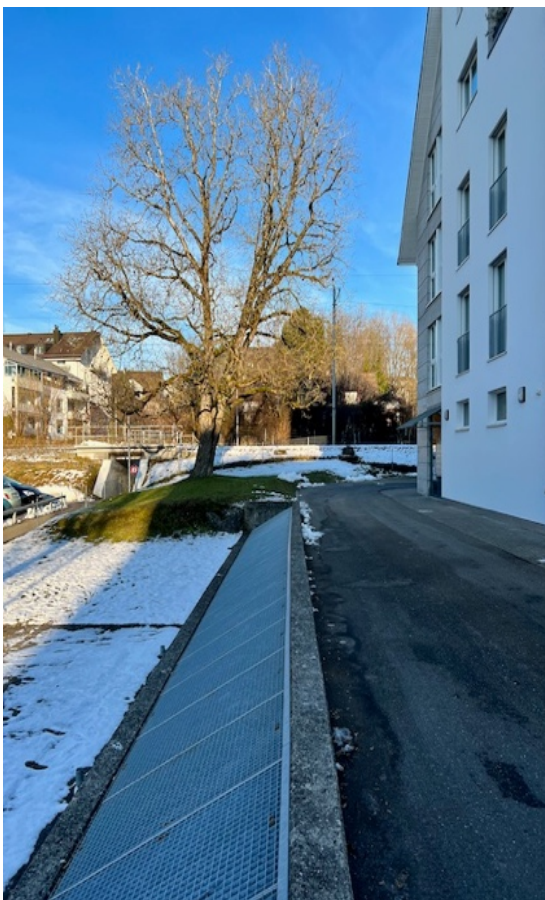
Eingedolter Dorfbach unter dem Gitterrost, Tunnelweg beim Kreisel © ARIAS Industriekultur
