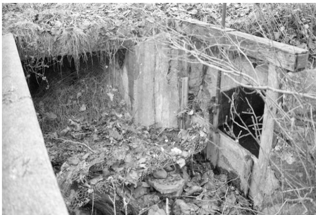
Verschlammte Verzweigung mit Hubschütz, Ein- und Überlauf © ARIAS Industriekultur, ETH E-Pics Stiftung H.P. Bärtschi
