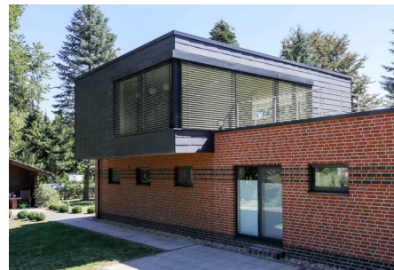
Referenzbilder realisierter Attikageschosse
