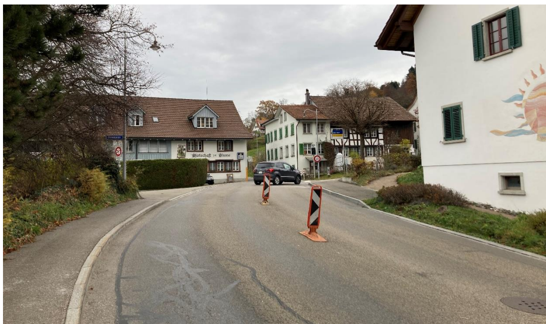
Abbildung 4: Leitbacken im Kurvenbereich vor der südlichen Zufahrt Engstelle Wetzikerstrasse
