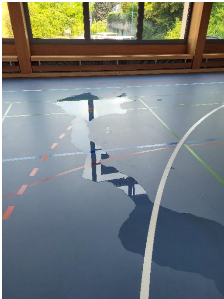
Fotos: Wassereintritt nach Abschluss der 2. Sanierungsetappe am 19.8.2022
