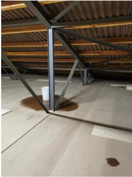
Fotos: Wassereintritt nach Abschluss der 2. Sanierungsetappe am 19.8.2022
